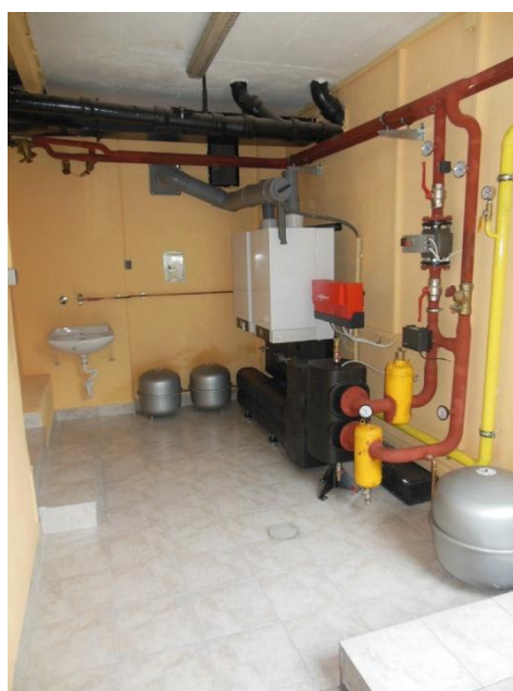
Slika 8: Prenovljena kotlovnica na Hrušici 70
