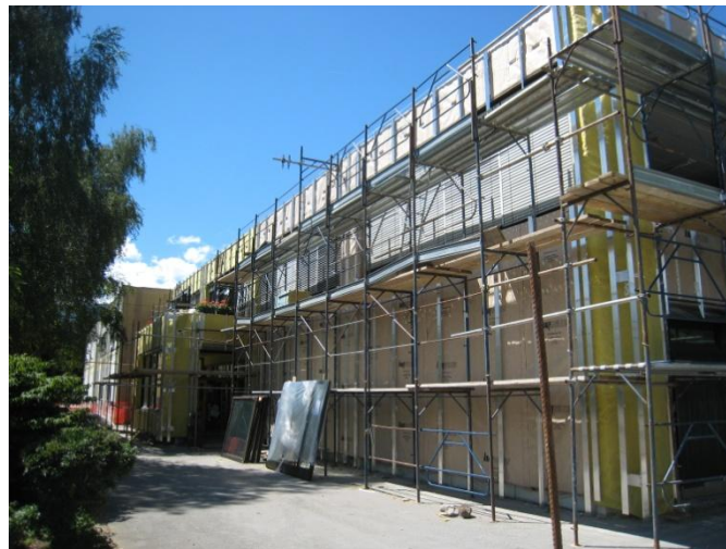
Slika 7: Dela med sanacijo fasade OŠ Antona Tomaža Linharta
